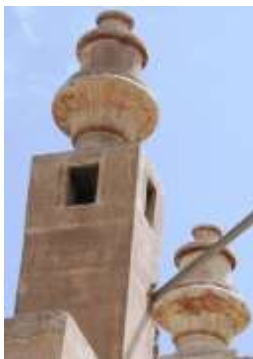
لوحة (8) نموذج لبعض مداخن القصر.
